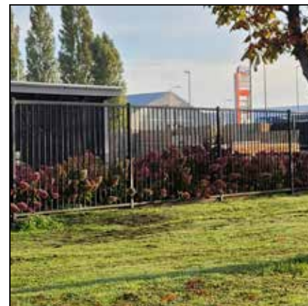
Neutrale hekwerken deels begroeid met beplanting met meer sierwaarde
